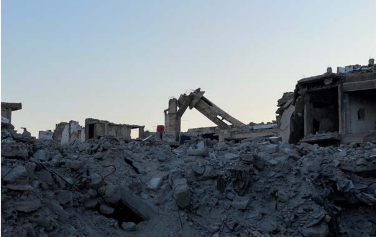
Sivillerin açlığa mahkûm edildiği Yermuk bölgesinde Esed rejimi tarafından gerçekleştirilen yıkım, Fotoğraf: TİHEK, 2025.
